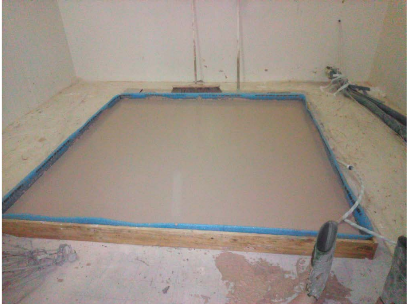
Sistema Uponor 90 mm. Cobertura con mortero.
