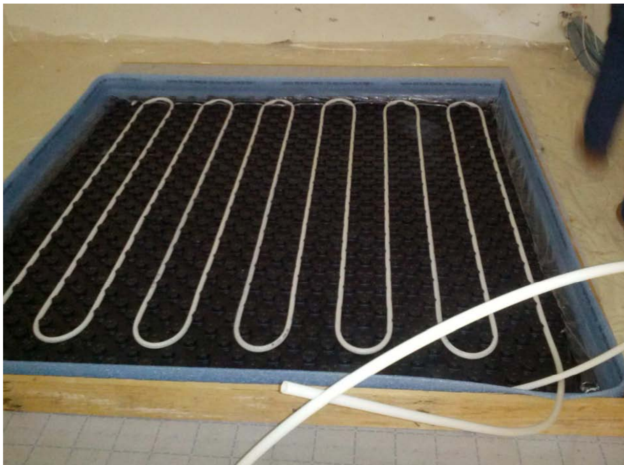
Sistema Uponor 84 mm. EPS y tubo antes de cubrir con mortero.
