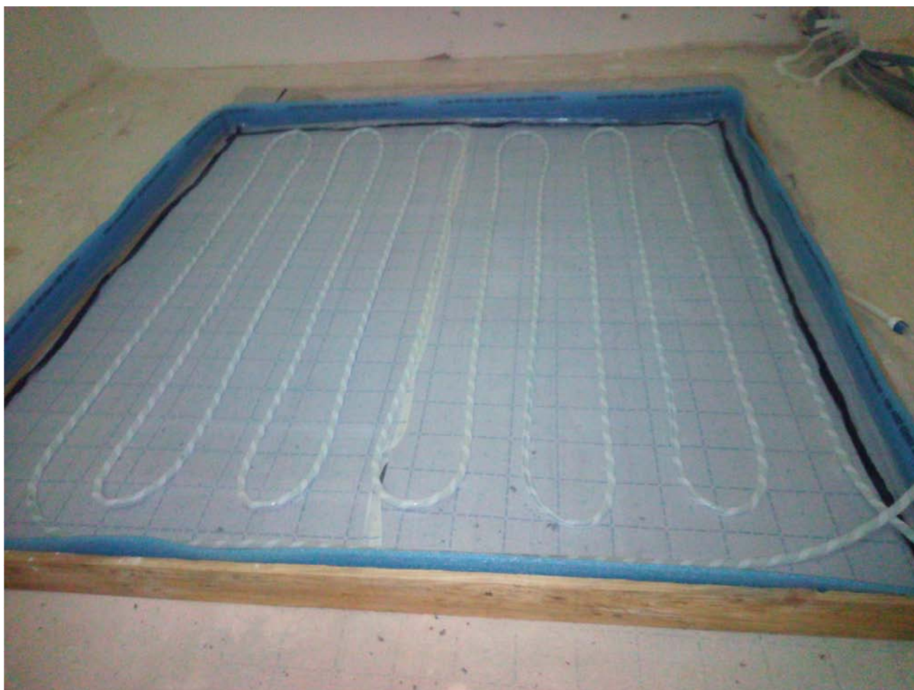
Sistema Uponor 90 mm. EPS y tubo antes de cubrir con mortero.
