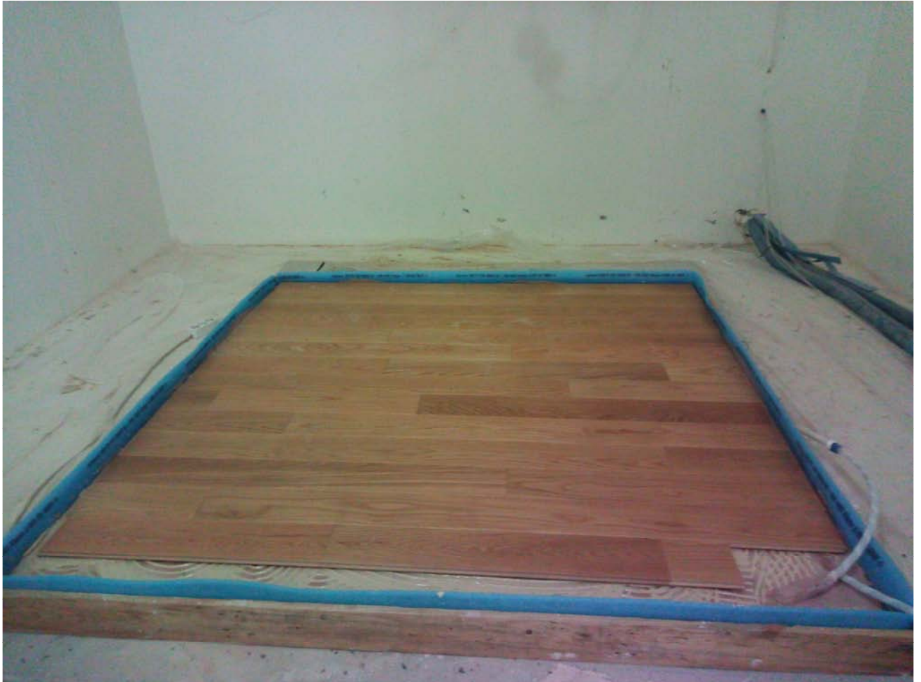
Sistema Uponor 90 mm. Instalación de la madera.
