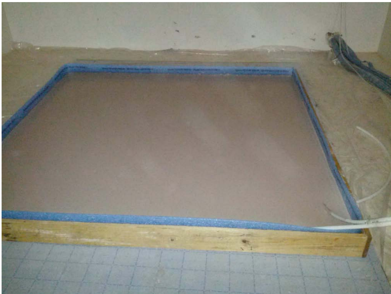
Sistema Uponor 84 mm. Cobertura con mortero.
