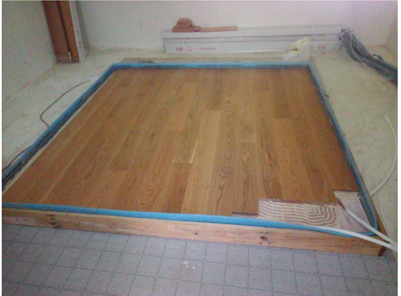
Sistema Uponor 84 mm. Instalación de la madera.
