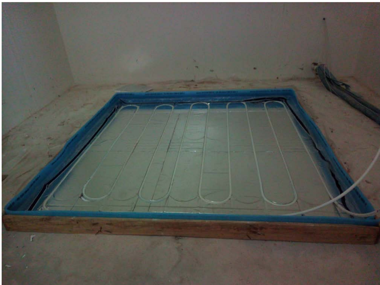
Sistema Uponor 49 mm. EPS y tubo antes de la colocación de la madera.
