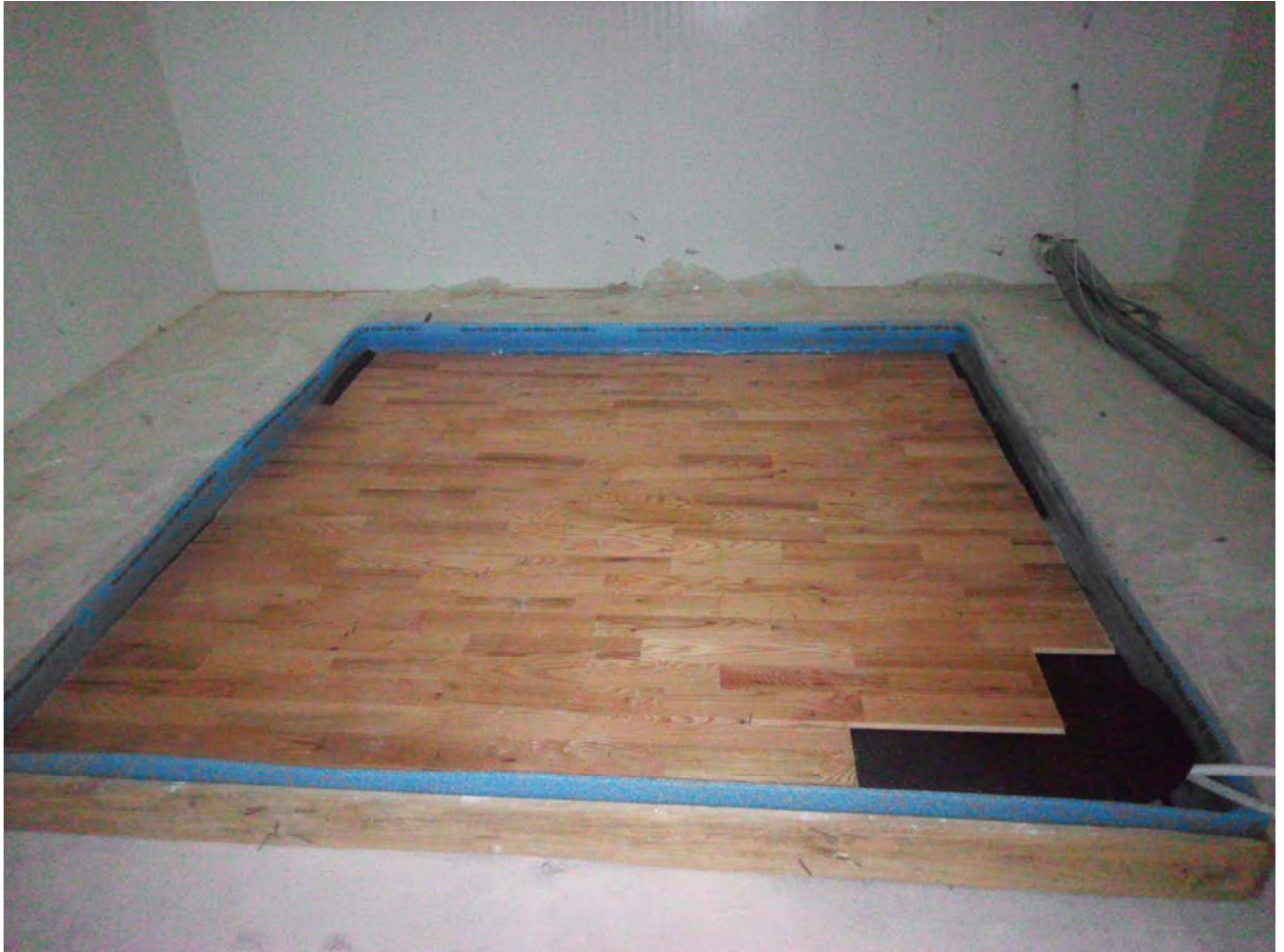
Sistema Uponor 49 mm. Instalación de la madera.
